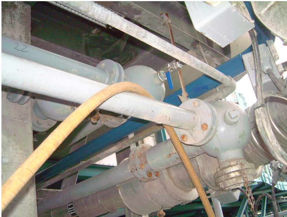
Abbildung 3: Kugelumlenkung mit direkter Erweiterung der Rohrleitung
