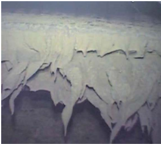
Ascheanbackungen im Eco einer Müllverbrennungsanlage
