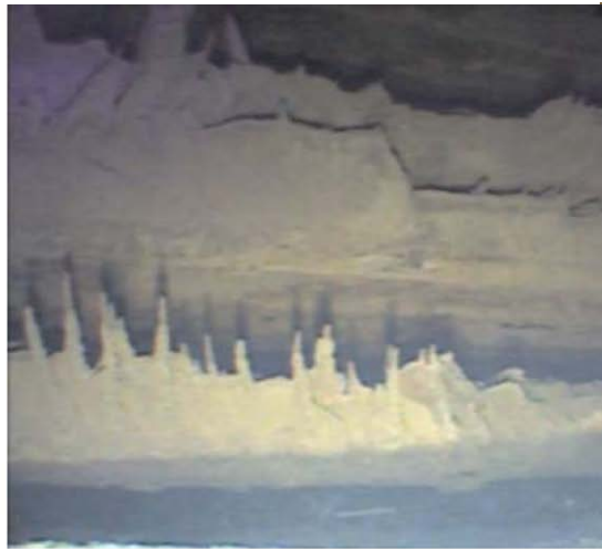
Ascheanbackungen im Eco einer Müllverbrennungsanlage
